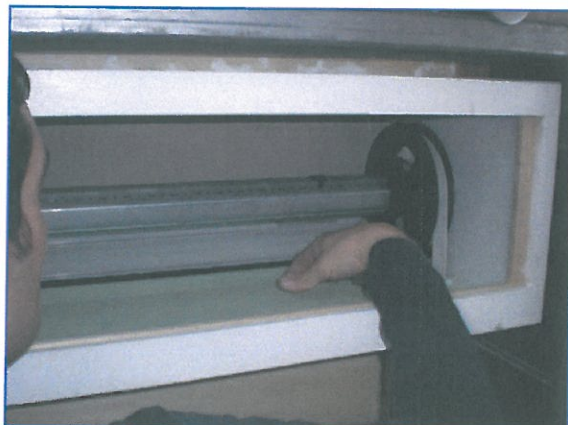
Posizionamento dei fianchi, della barra di contenimento superiore, della coibentazione inferiore e del pannello frontale
